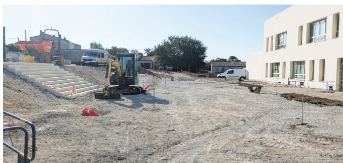
Aménagement de la 2ème cour d'école.
