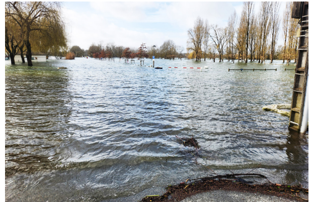
Le Communal au début de la crue
